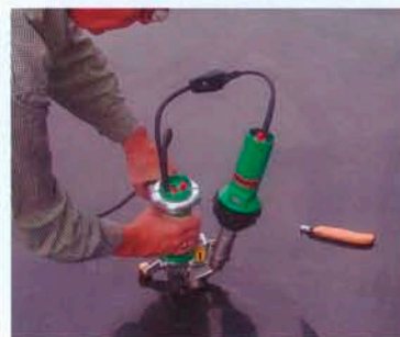
Быстрая прихватка заплаты н гидроизоляции из ПЭВД перед сваркой экструдером.
