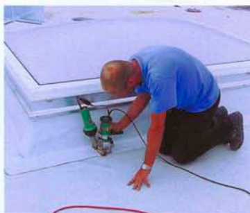
Сварка кровельного покрытия на крыше в зоне примыкания.
