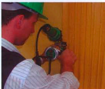
ТриакДрайв при сварке покрытия в компенсационных швах в туннеле.
