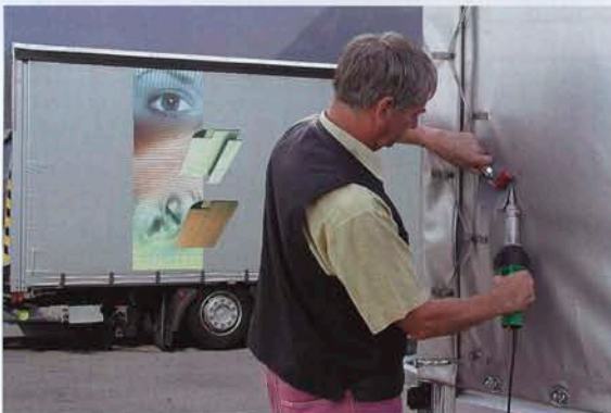
Аппарат ТРИАК PID с щелевой насадкой 20 мм и прикаточный ролик при ремонте тентового покрытия грузового автомобиля.
