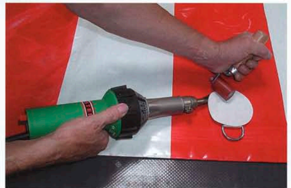
Наварка крепежной накладки при помощи Триак S.
