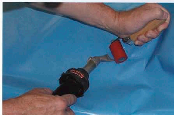
Ремонт покрытия бассейна аппаратом Хот-Джет S.
