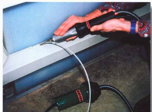
Аппарат Диод S с охлаждаемой защитной трубкой. Подача воздуха – от вентилятора Минор.
