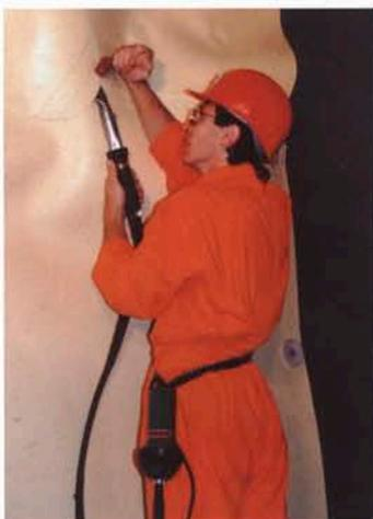
Диод PID и MINOR при сварке гидроизоляции из ПВХ при строительстве тоннеля
