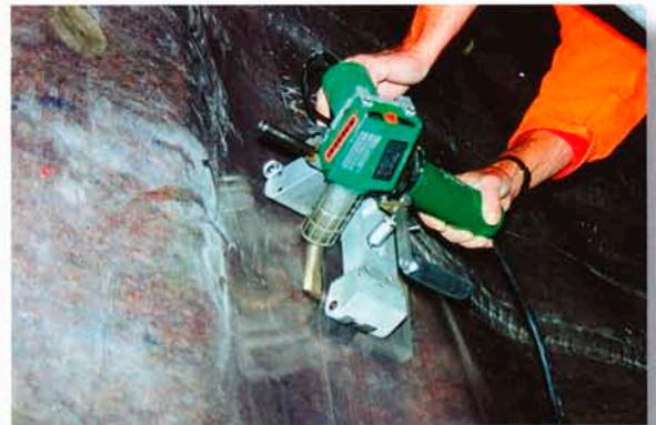
ТВИННИ S с коротким комбинированным клином при сварке гидроизоляции в тоннеле.
