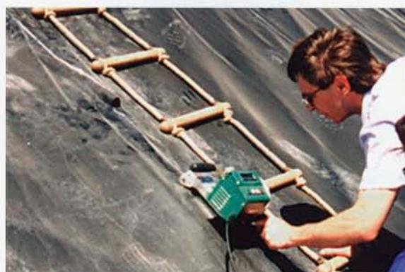
Сварочный автомат КОМЕТ при сварке геомембраны на строительстве мусоросборочного полигона.
