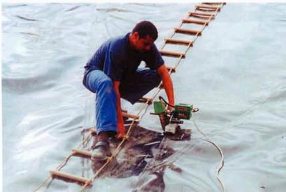
ТВИННИ Т при сварке геомембраны из ПЭНД толщиной 1,5 мм на строительстве мусоросборного полигона. Шов – с проверочным каналом.
