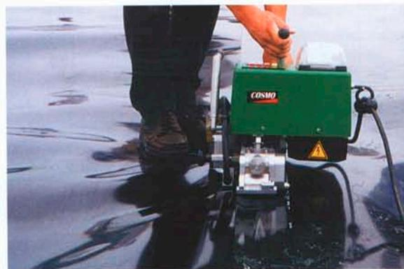
Автомат КОСМО при сварке геомембраны из ПЭНД толщиной 2,5 мм.
