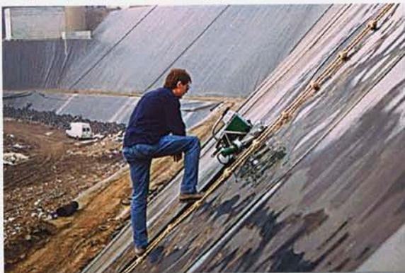
Комбинированный клин автомата ТВИНМАТ позволяет получать безупречные швы даже в сырую погоду.
