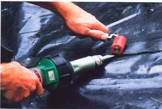
Аппарат ТРИАК PID при сварке геомембраны из ПЭВД.
